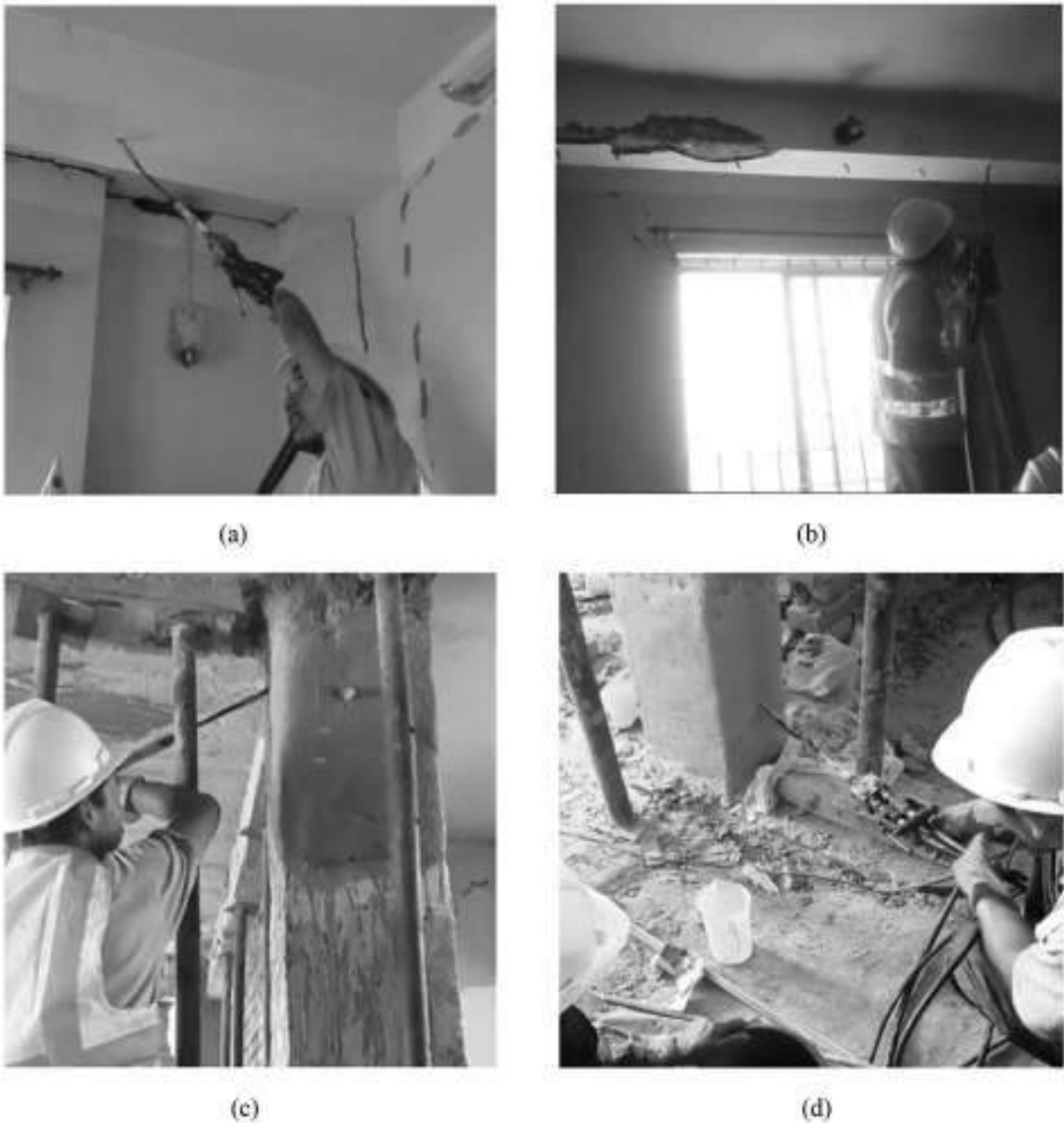
Fig. 19. Injecting Epoxy grout in beams (a), (b) and columns (c), (d)
