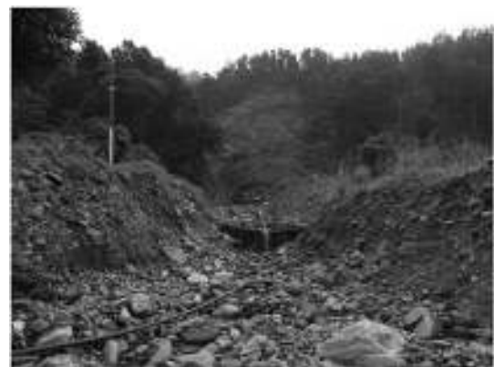
Fig. 10. – Destructive landslide, Pairebesi, Rasuwa 2018.
